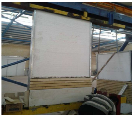
شکل (۸) نمای کلی دیوار در حال ساخت
