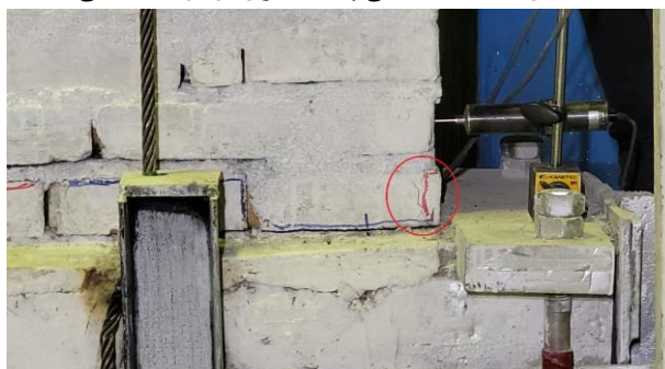
شکل ۳۳: ترک‌های ناشی از فشار ایجاد شده در پنجه دیوار در دریفت نسبی 0.40\%
