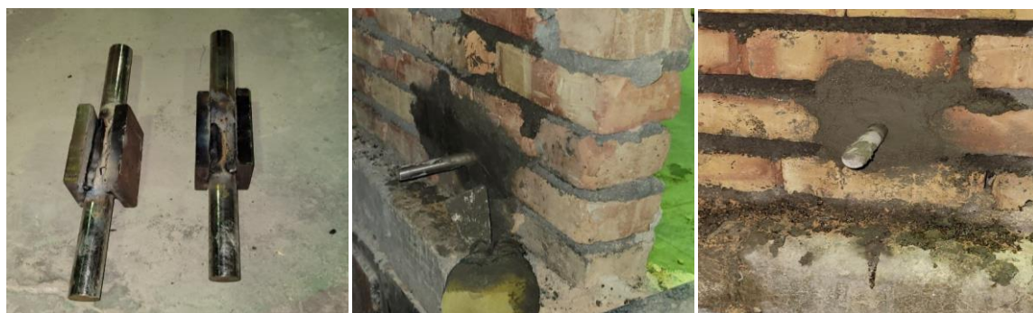
شکل ۲۰: ساخت و نصب میلگردهای محل تغییر زاویه تاندون ها
