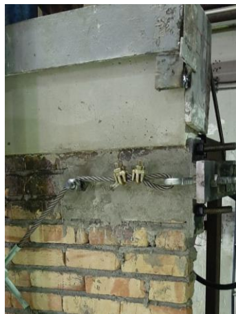
شکل ۲۲: تقویت رج‌های فوقانی دیوار با بتن الیافی
