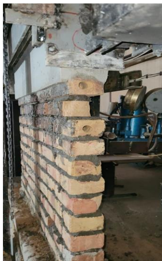
شکل ۱۹: سوراخکاری مقطع کناری دیوار جهت کاشت میلگرد
