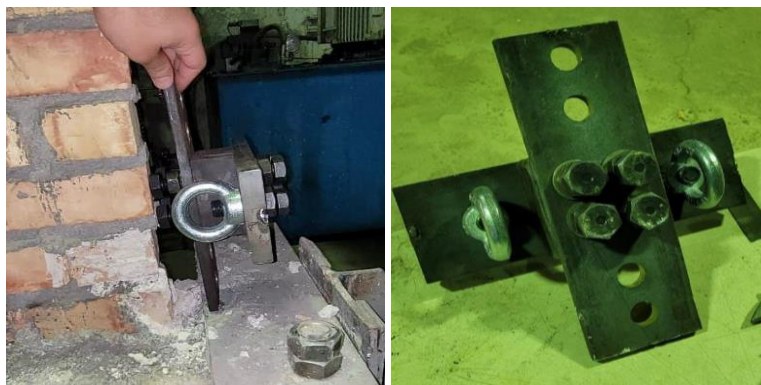
شکل ۱۸: قطعه واسط متشکل از ورق فولادی و نئوپرن
