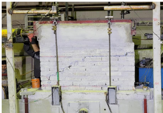
شکل ۳۴: ترک های لغزشی - قطری در دریفت نسبی ۰.۶٪
